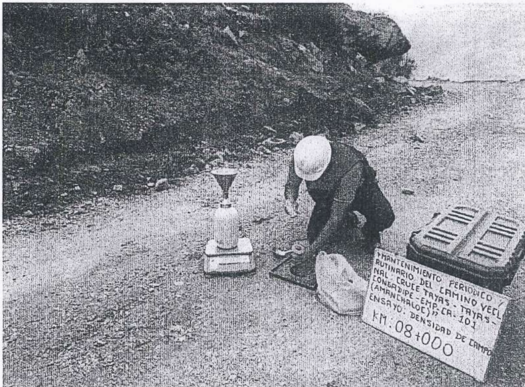
Fotografía N° 2. Ensayo de Densidad de Campo en la progresiva Km. 8+000
