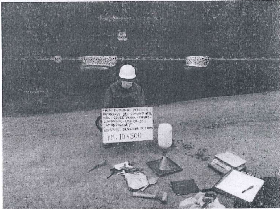
Fotografía 25. Densidad de campo el km 10+500.
