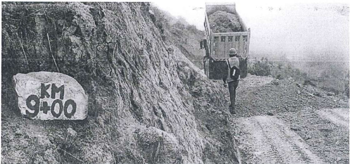
Fotografía 11. Volquetes realizando trabajos de des carguío de material en la vía
