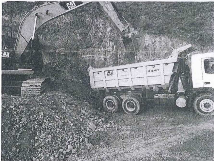
Fotografía 5. Carguío de material granular para afirmado.
