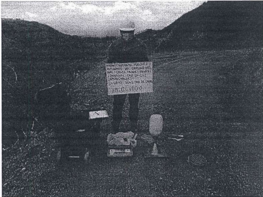
Fotografía 6. Densidad de campo el km 06+000.
