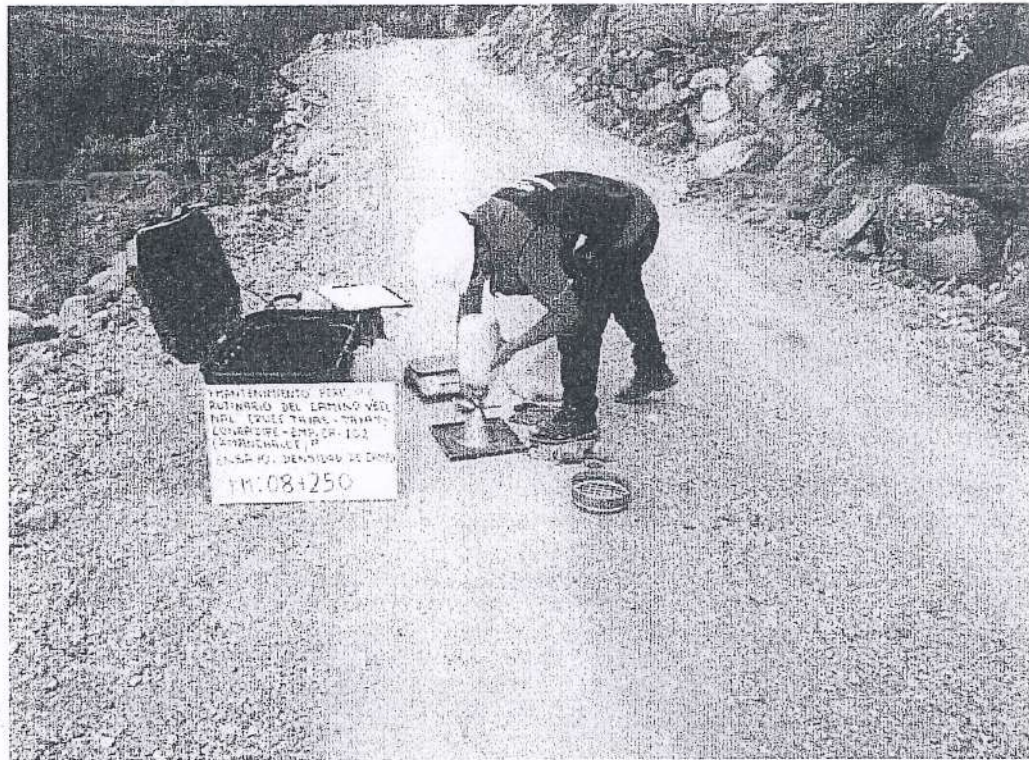
Fotografía N° 3. Ensayo de Densidad de Campo en la progresiva Km. 8+250
