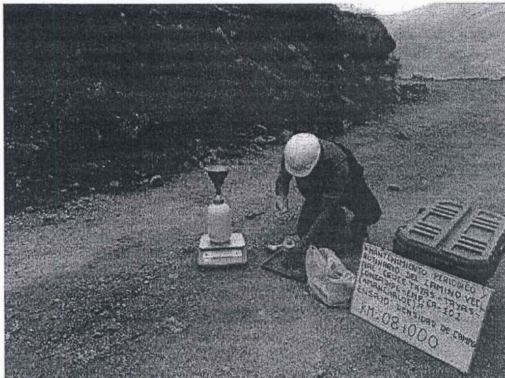
Fotografía 7. Densidad de campo el km 08+000.
