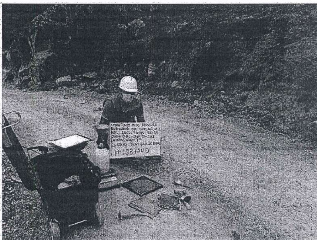
Fotografía 8. Densidad de campo el km 08+500.
