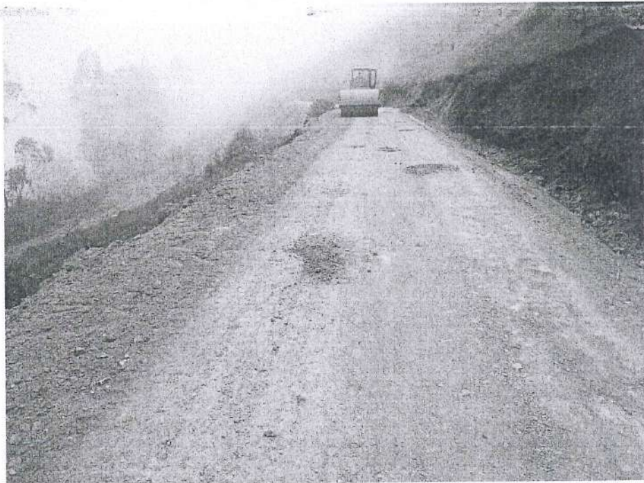
Fotografía 10. Rodillo realizando trabajos de compactación en la vía.
