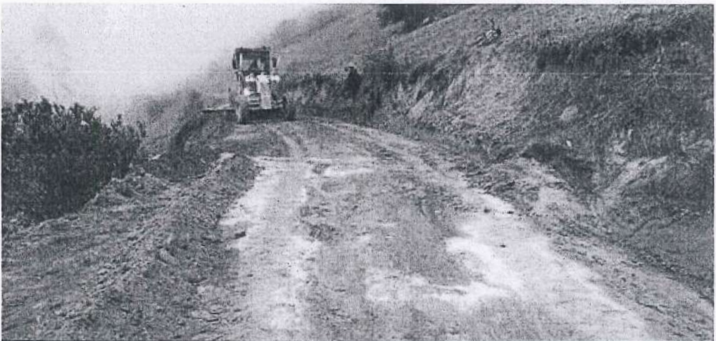
Fotografía 3. Motoniveladora realizando trabajos de escarificado de la vía.
