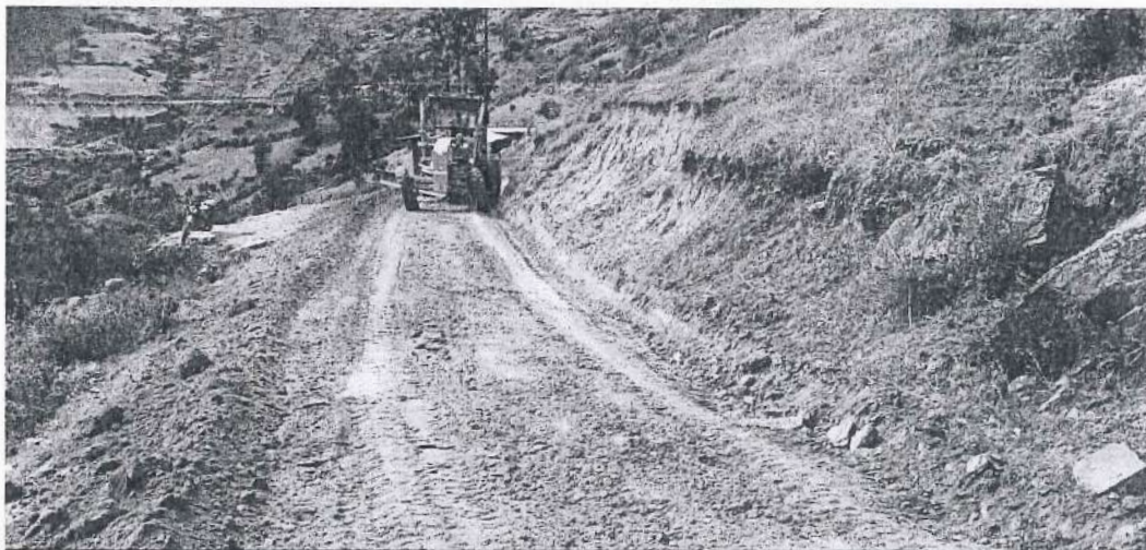
Fotografía 13. Motoniveladora realizando trabajos de extendido de material granular en la vía.
