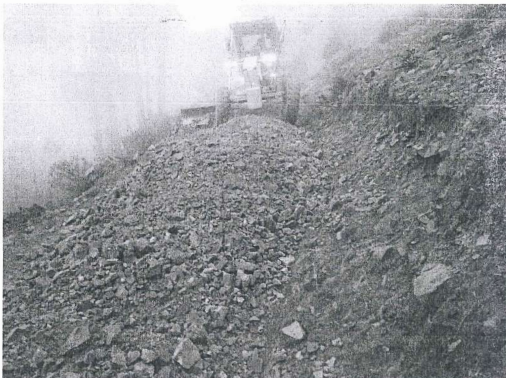
Fotografía 6. Motoniveladora realizando trabajos de extendido de material granular en la vía.
